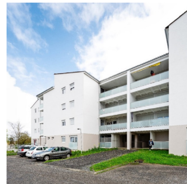
Ravalement de façade du bâtiment B à la Couronne
