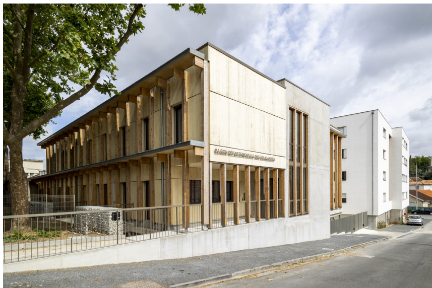
La nouvelle MDS construite pour le compte du Département prend place derrière l'extension du FJT. (photo Pauline Turmel)
