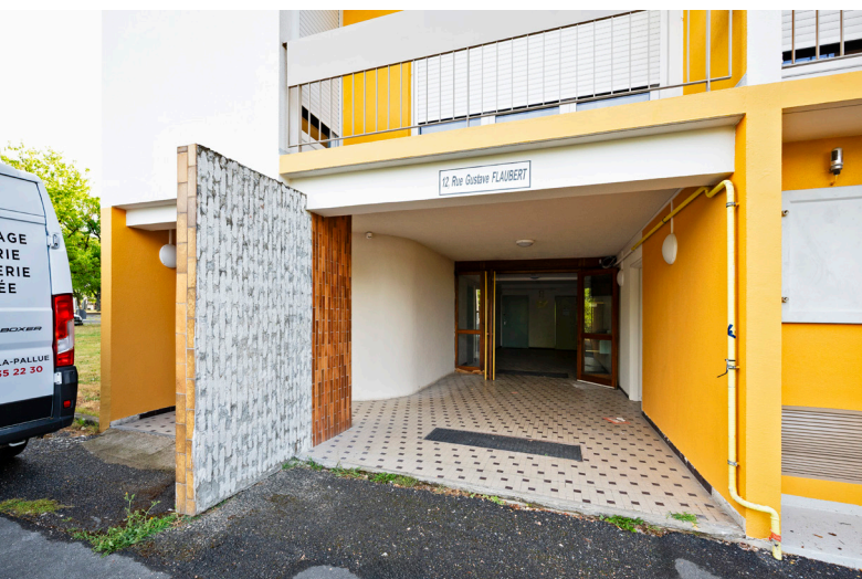
Hall d'entrée avant les travaux de sécurisation (photo Julia Hasse)
