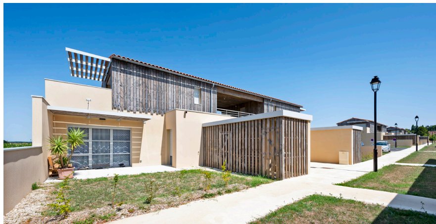
32 logements ont été livrés à Segonzac (photo Julia Hasse)
