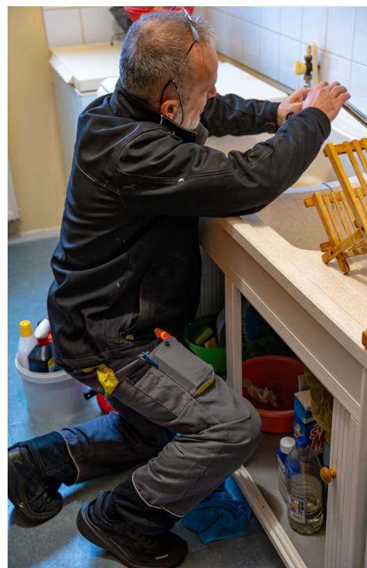
Des réparations supplémentaires seront intégrées au contrat. (photo Encore-Design)
