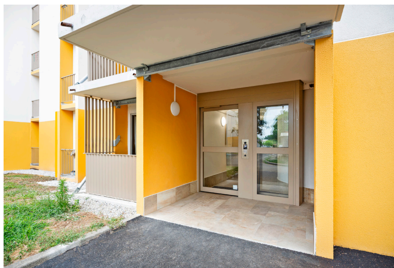
Après les embellissements des communs et pose des portes coulissantes sous contrôle d'accès (photo Julia Hasse)
