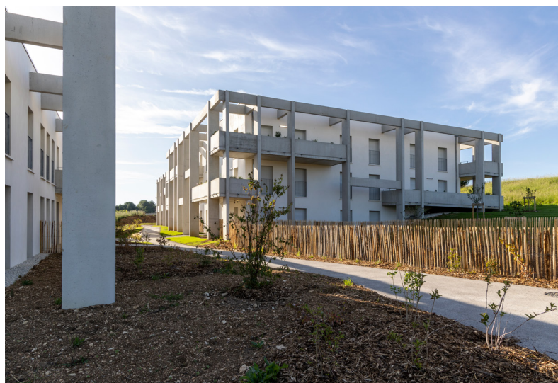
39 appartements sont en construction à Ruelle (photo Pauline Turmel)
