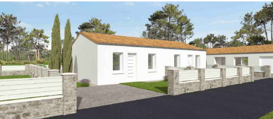
La construction de huit pavillons est en cours à Vouzan (visuel projet Notre Maison)
