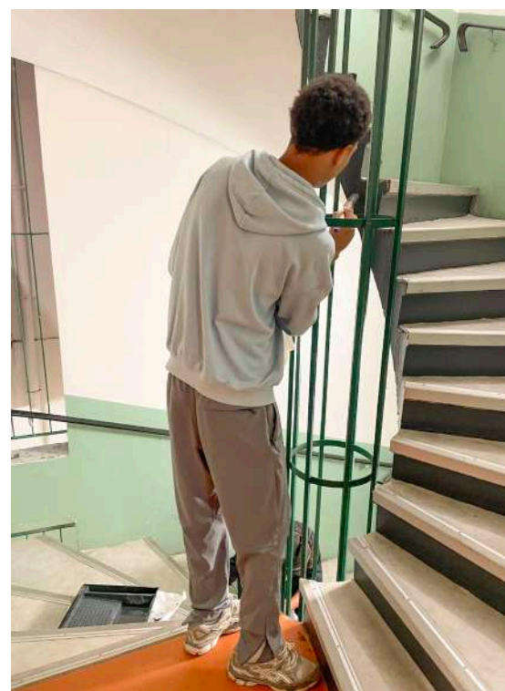
Deux jeunes encadrés par l'ADSEA 86 ont repeint une cage d'escalier à La Couronne
