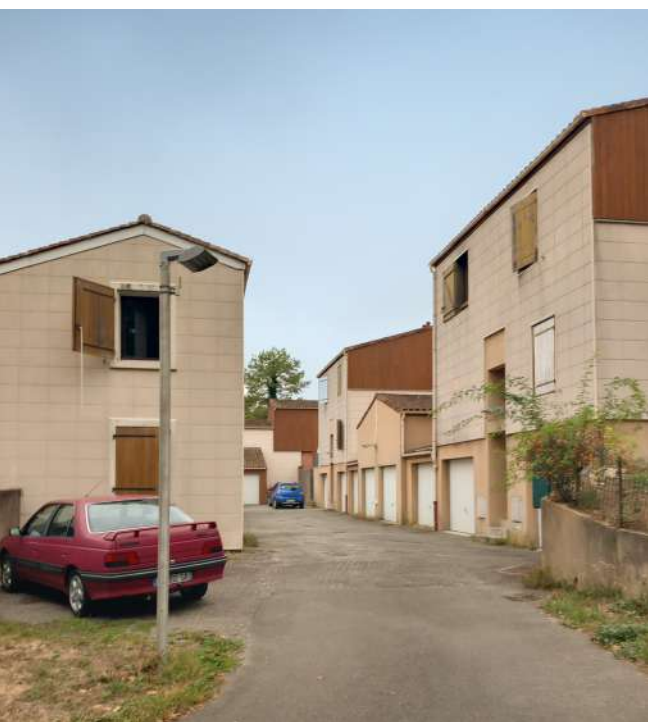
Les 20 pavillons de la Résidence du Parc, à Saint Amant de Boixe, seront déconstruits et reconstruits.
