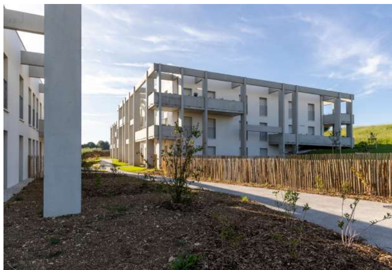
39 appartements sont en construction à Ruelle (photo Pauline Turmel)
