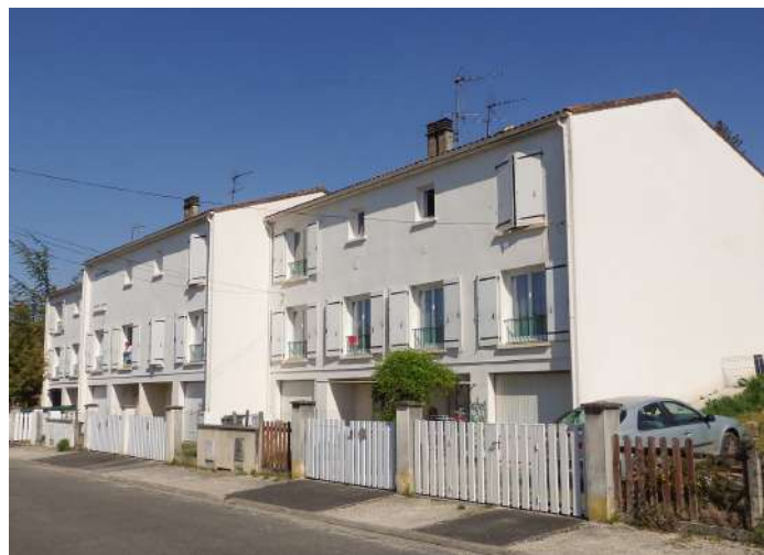
A Montmoreau, 18 logements seront entièrement rénovés.
